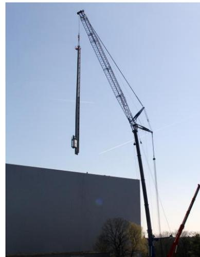
Bild 1+2: Anheben des Regalbediengerätes zum Einbringen in das neue Hochregallager
